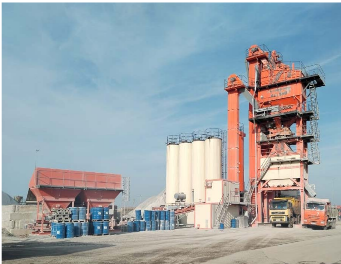
Рис. 6 Асфальтосмесительная установка КА-160-6F
